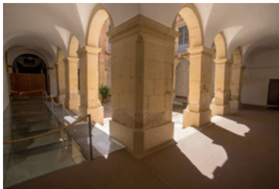
Figura 83. Imagen interior de la galería del claustro en planta baja.
