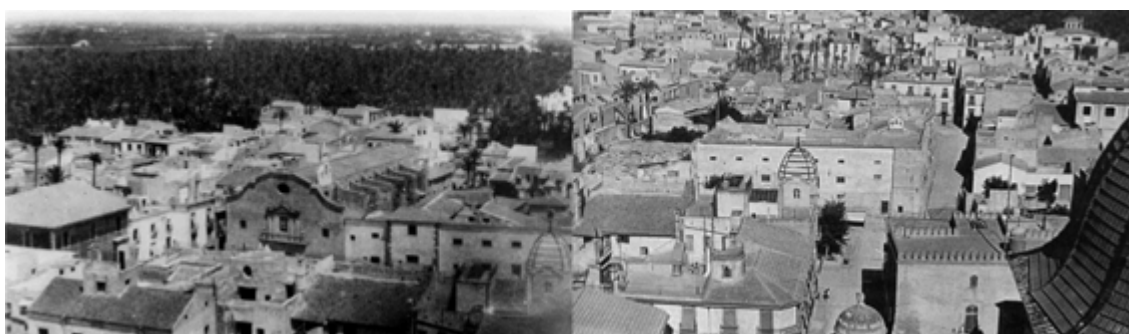
Figura 12. Fotografías del Convento de la Merced – Clarisas a principios de la década de 1930 (a la izquierda) y con posterioridad al incendio y destrucción de la iglesia de finales del siglo XVIII y del extremo septentrional del Convento.
