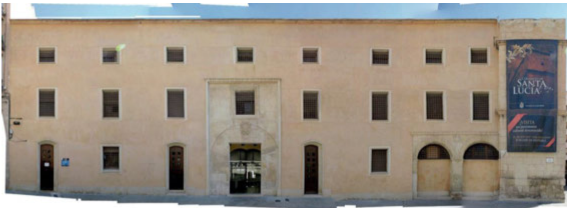
Figura 68. Alzado de la fachada oeste del conjunto patrimonial. Acceso principal actual.
